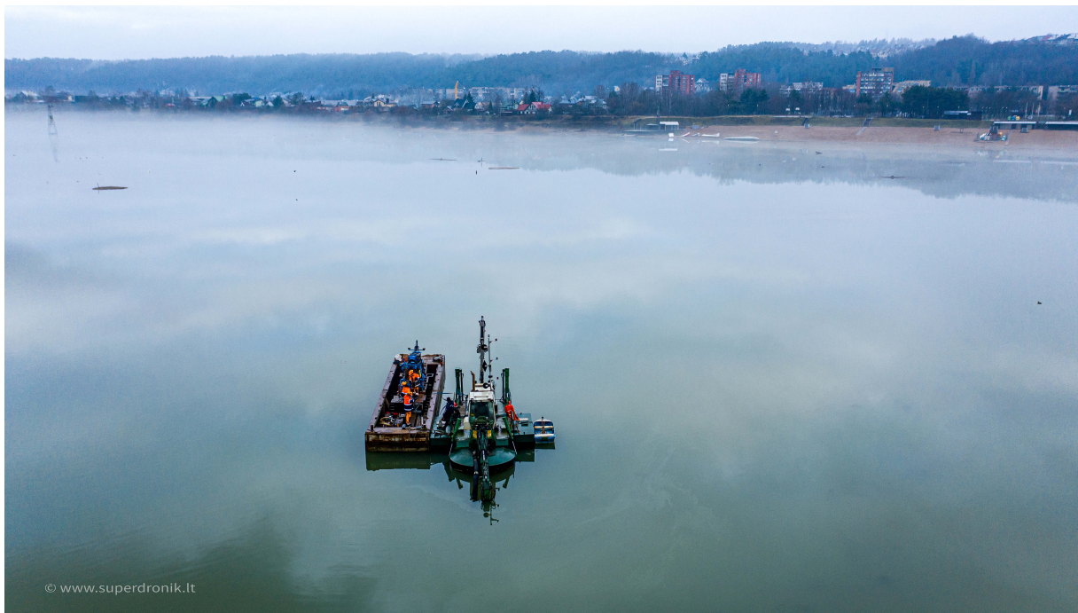
1 pav. Lauko darbai
